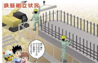
B-8 強い橋にするためにコンクリートの中に鉄筋を入れるんだよ
