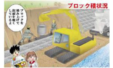
C-6 ブロックを積み上げて法面を強くしているよ
