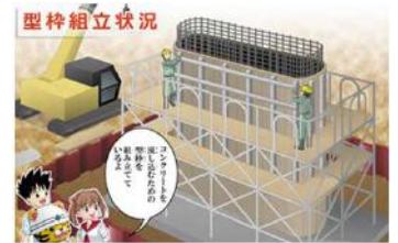
B-9 コンクリートを流し込むための型枠を組み立てているよ
