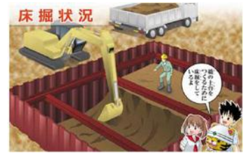
B-6 端の土台をつくるために床掘をしているよ
