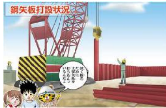
B-5 深く掘るために土留を打ち込んでいるんだよ
