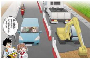
A-1 新しい舗装するために古い舗装を壊しているんだよ
