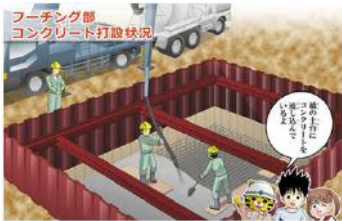
B-7 橋の土台にコンクリートを流し込んでいるよ
