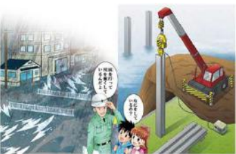
C-13 なにをしているの？杭を打って川を強くしているんだよ
