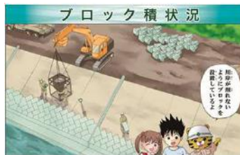
C-17 川岸が削れないようにブロックを設置しているよ
