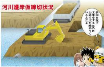
C-4 洪水を防ぐ工事をするために土砂で川を締切っているんだよ
