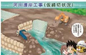
C-16 ブロックを設置するために川を仮締切しているよ
