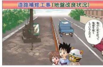
A-5 地中に杭を打って地盤を強くしているんだよ
