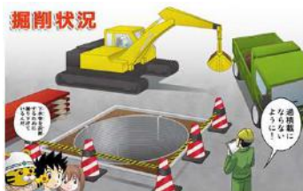
E-7 下水管を設置するために掘り下げているんだ
