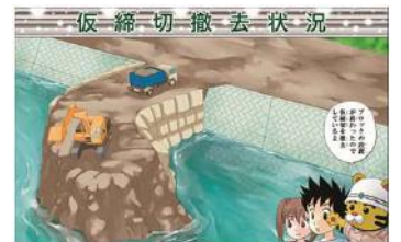
C-18 ブロックの配置が終わったので仮締切を撤去しているよ
